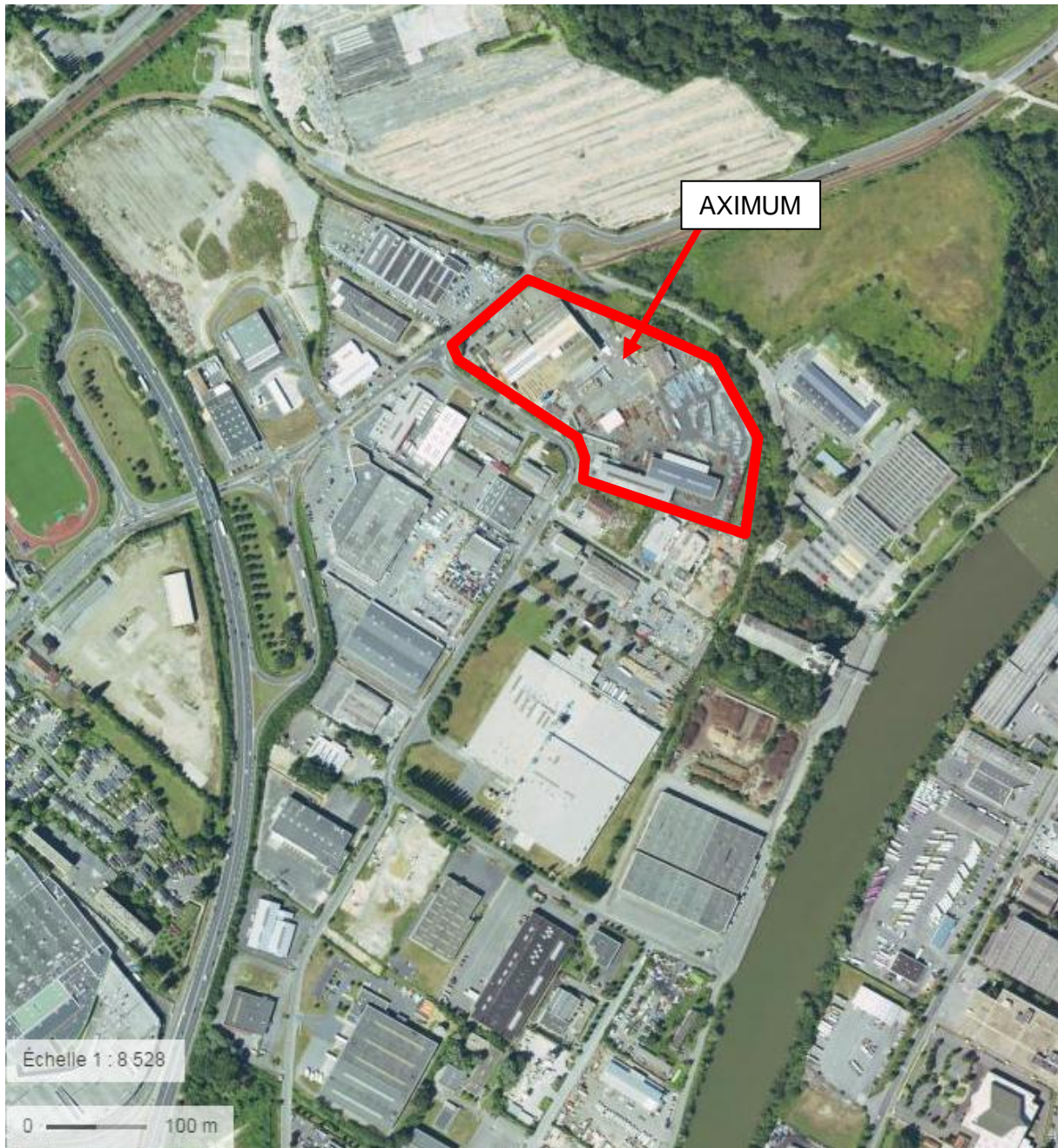
Figure 3 : Localisation du site dans la zone industrielle
